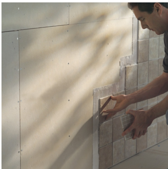
▲ به عنوان زیر کار کاشی و سرامیک در دیوارهای خشک
